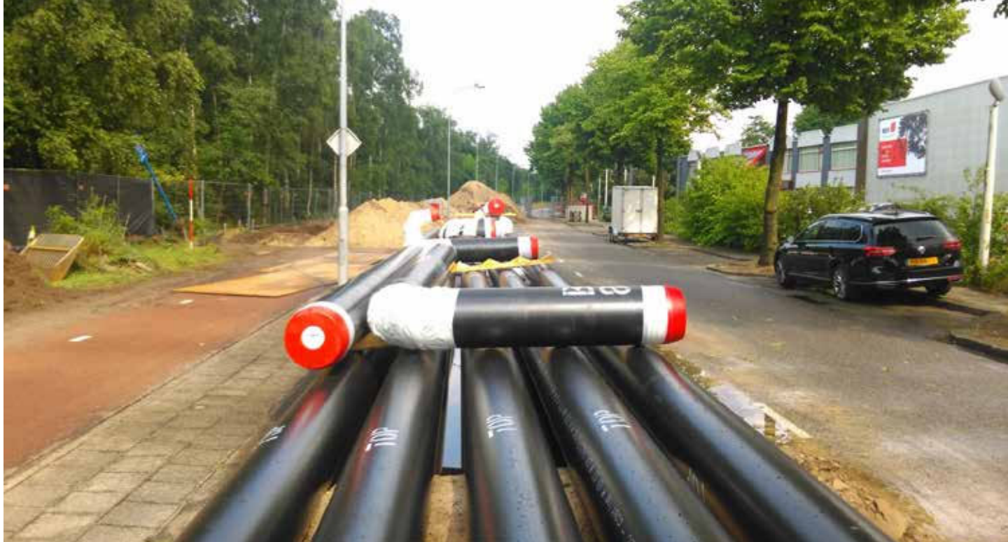
Aanleg van warmtenet (foto: Warmtebedrijf Ede)
